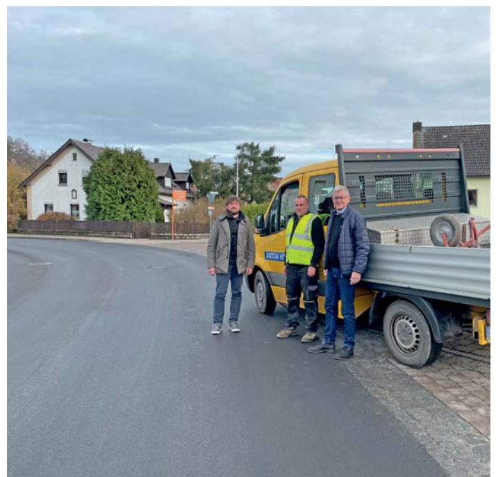
Erster Bürgermeister Wolfgang Möhrlein, Bautechniker Christian Nüsslein und Herr Seufferling von der Fa. Höllein konnten sich von der gelungenen Sanierung überzeugen.
