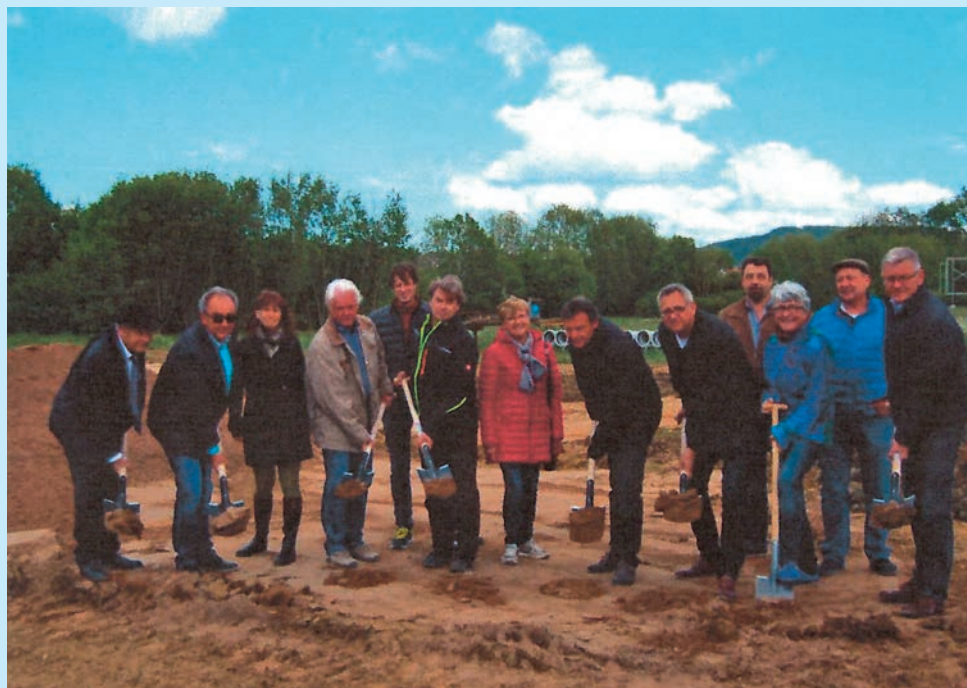
Litzendorfs Bürgermeister Wolfgang Möhrlein (rechts im Bild) mit Gemeinderäten und den Vertretern der am Bau beteiligten Firmen beim symbolischen Spatenstich
