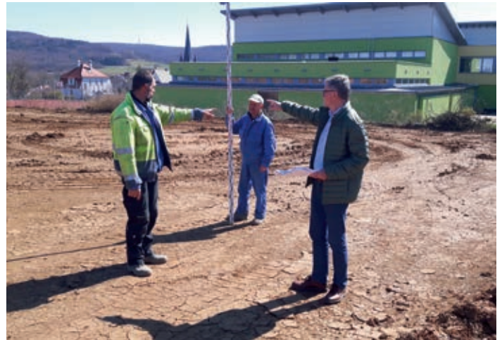
Bild: Baustelle Doppelsporthalle
