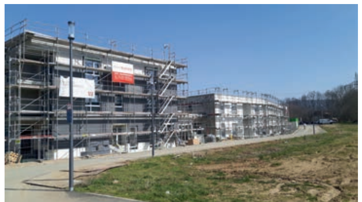
Bild: Seniorenwohnen Rohbau
